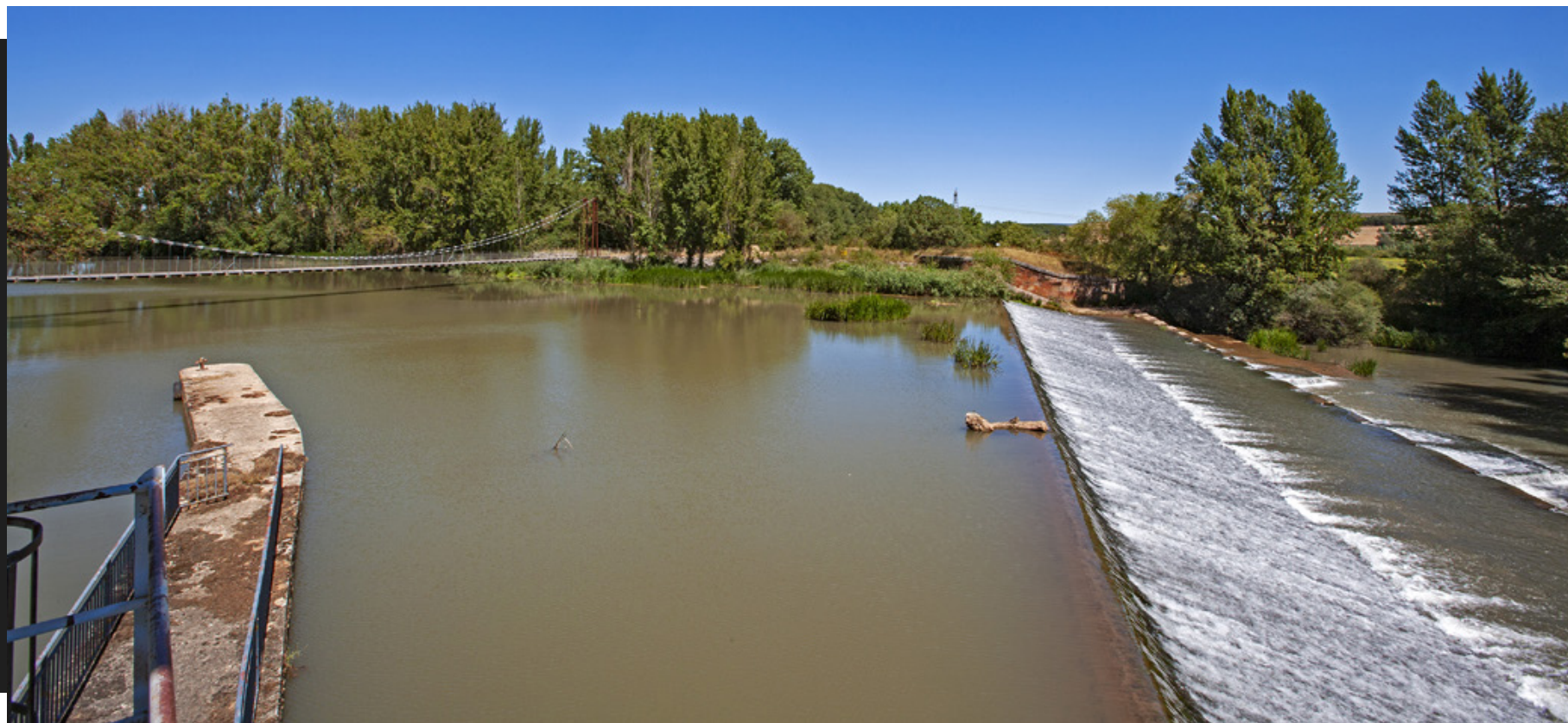
San Andrés Dam | Presa de San Andrés
