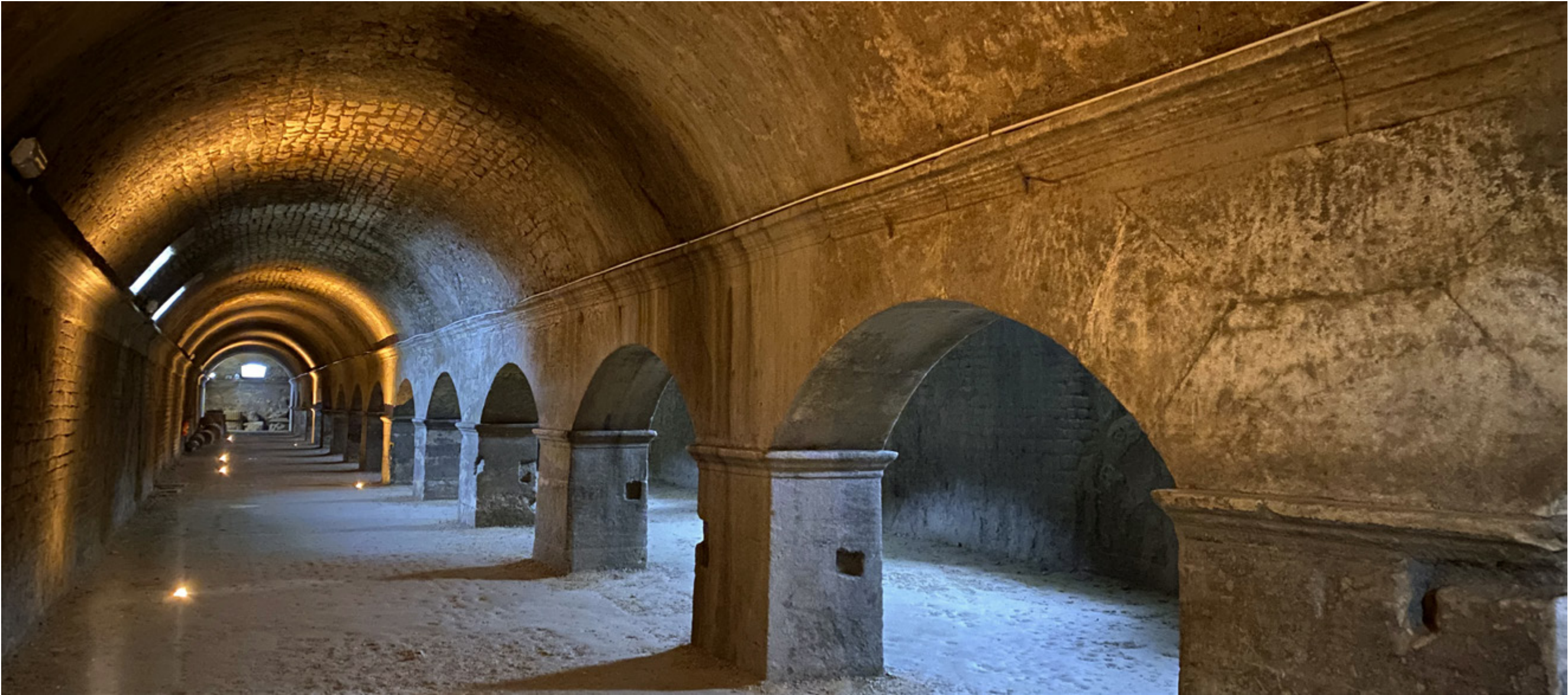
Cryptoporticos of Arles. Network of galleries that supported the Forum / Criptopórticos de Arlés. Red de galerías que sostenían el Foro
