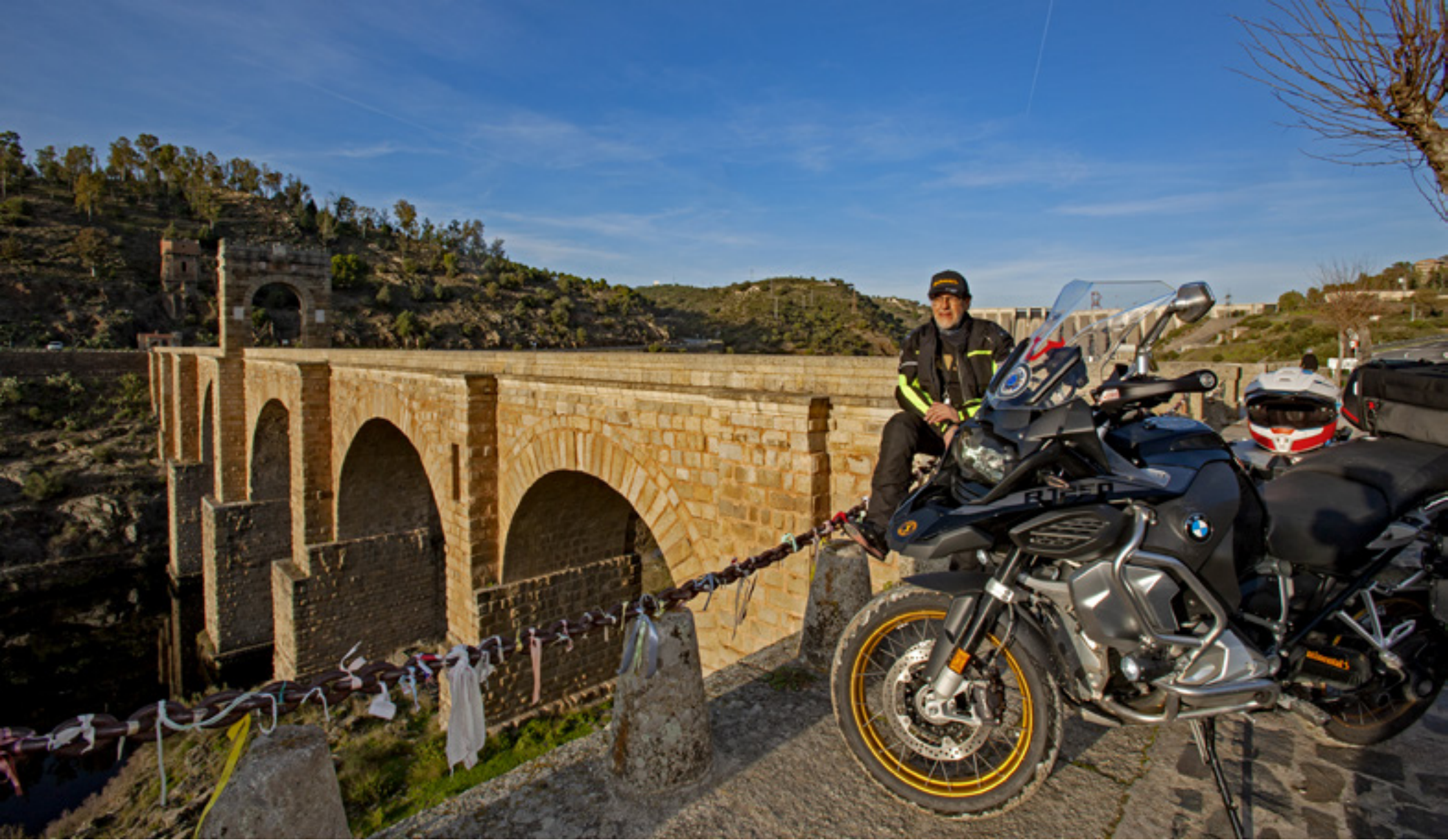
Roman bridge of Alcántara | Puente romano de Alcántara
