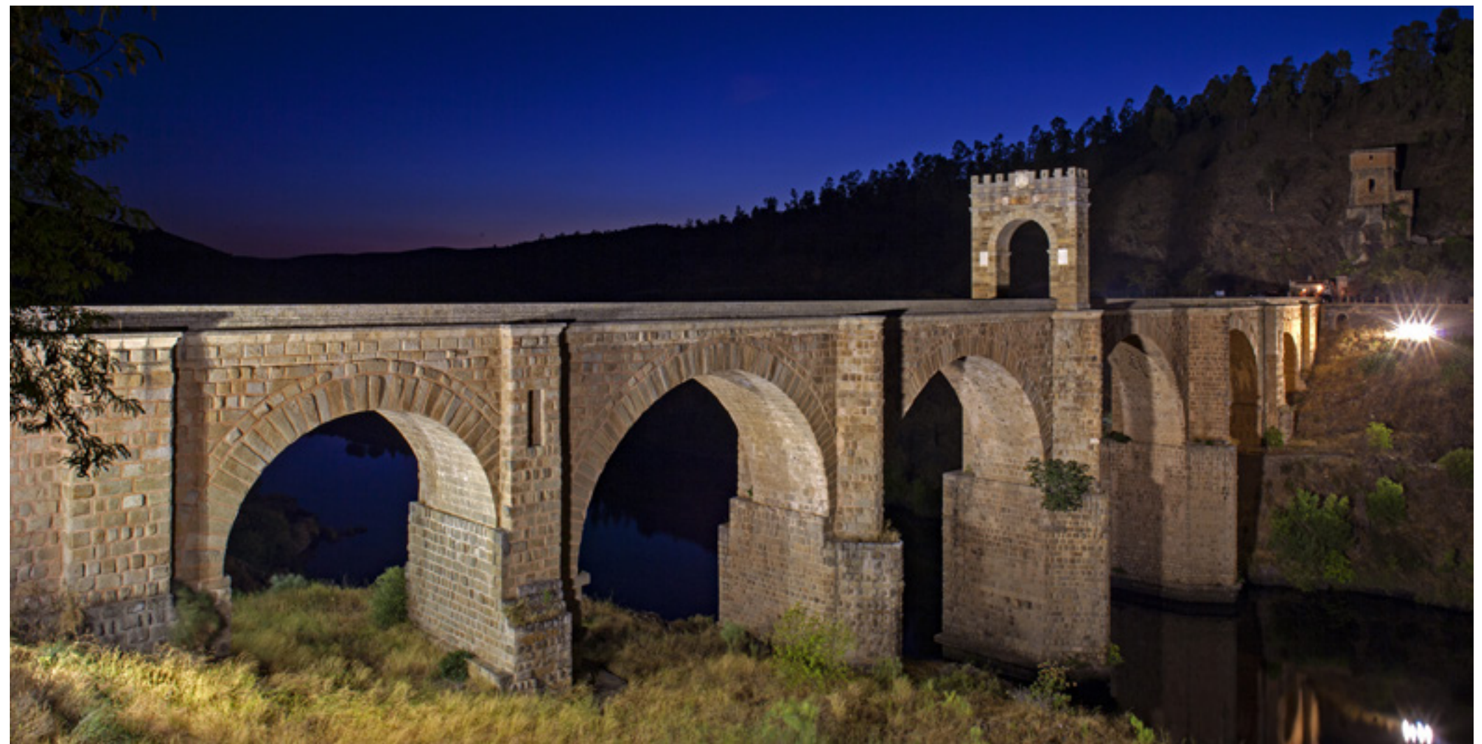
Puente romano de Alcántara | Roman bridge of Alcántara
