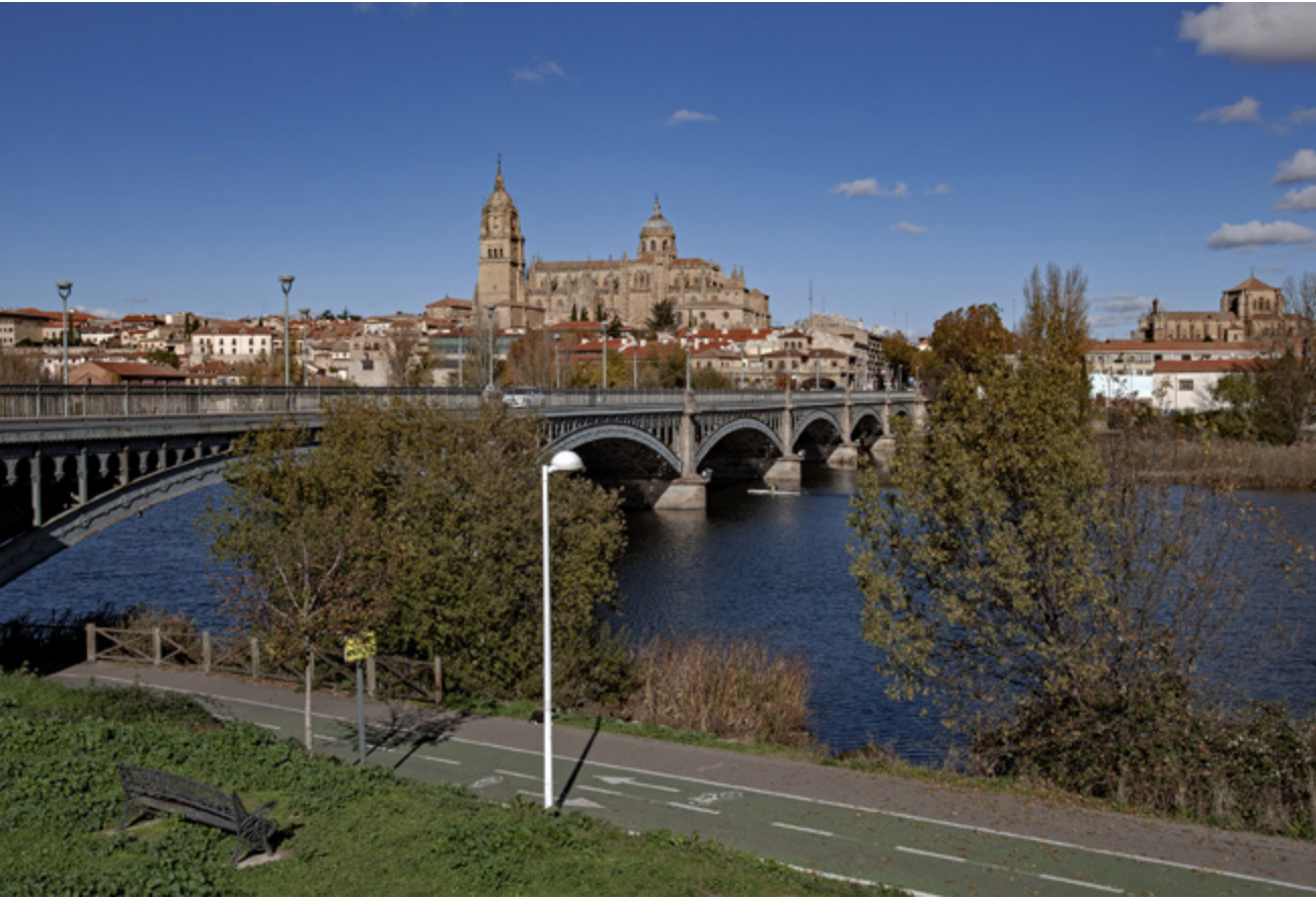
Puente Enrique Estevan sobre el río Tormes | Enrique Estevan Bridge over the Tormes River
