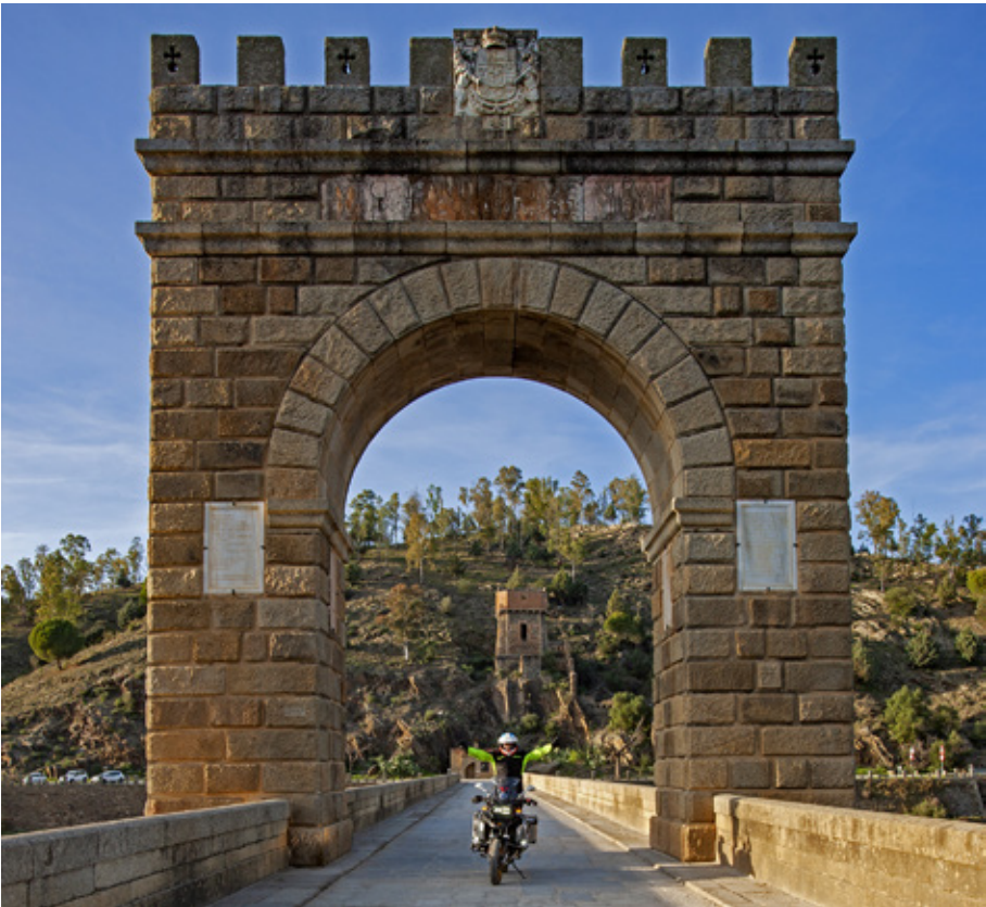
Puente romano de Alcántara | Roman bridge of Alcántara
