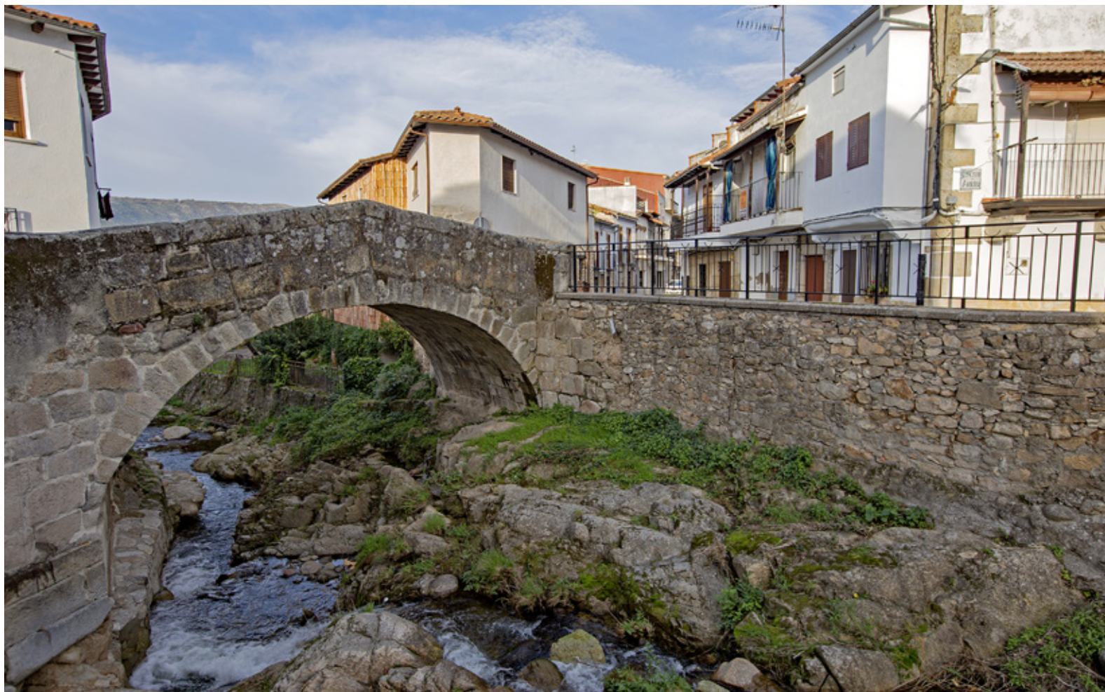
Bridge of Roman origin at Aldeanueva del Camino | Puente de origen romano en Aldeanueva del Camino
