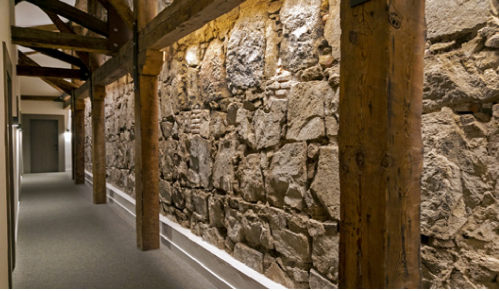
Piedra de sillería y vigas de madera originales | Ashlar and wooden beams originales
