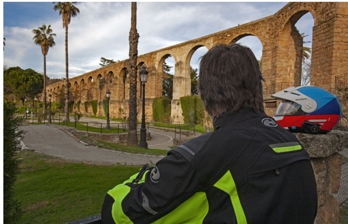
Plasencia Aqueduct | Acueducto de Plasencia
