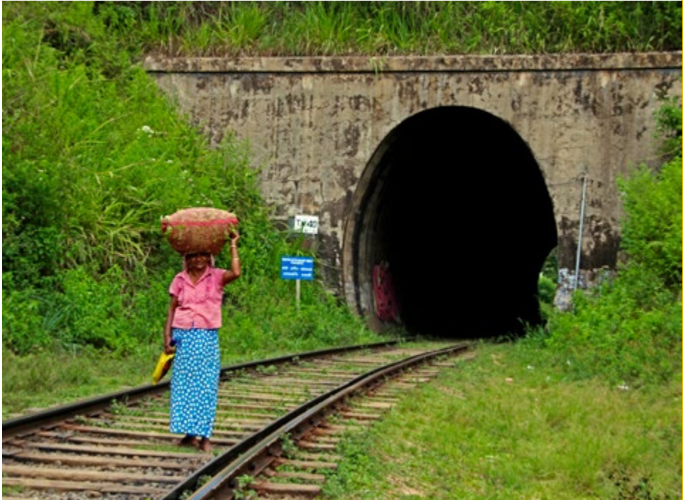
Tunnel exit at the Nine Arches Bridge | Salida de túnel en el puente de los Nueve Arcos
