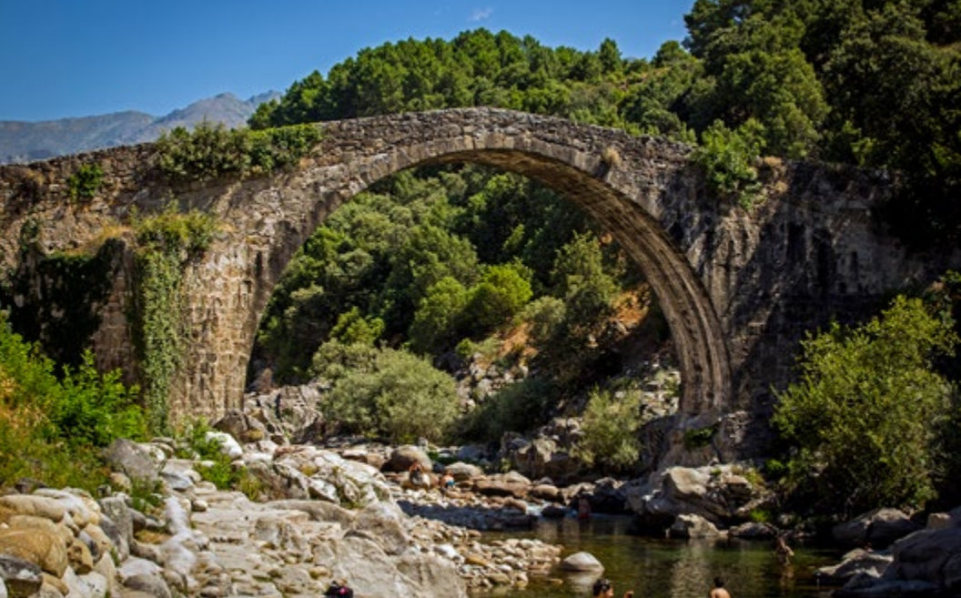
Puente en la Garganta de Alardos. Madrigal de la Vera | Bridge at the Garganta de Alardos. Madrigal de la Vera
