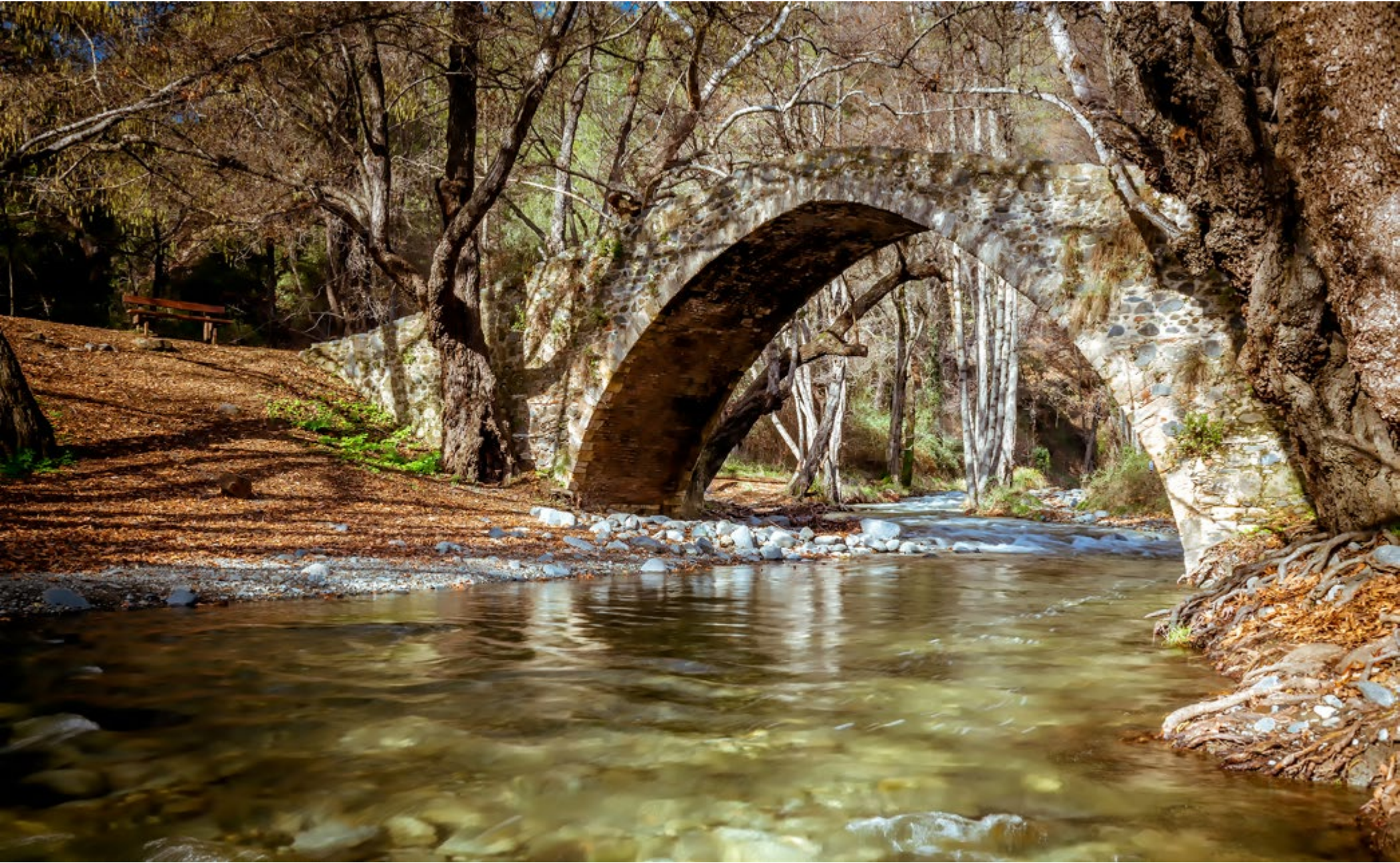
Puente en la ruta Kamilostrata | Bridge on the Kamilostrata route
