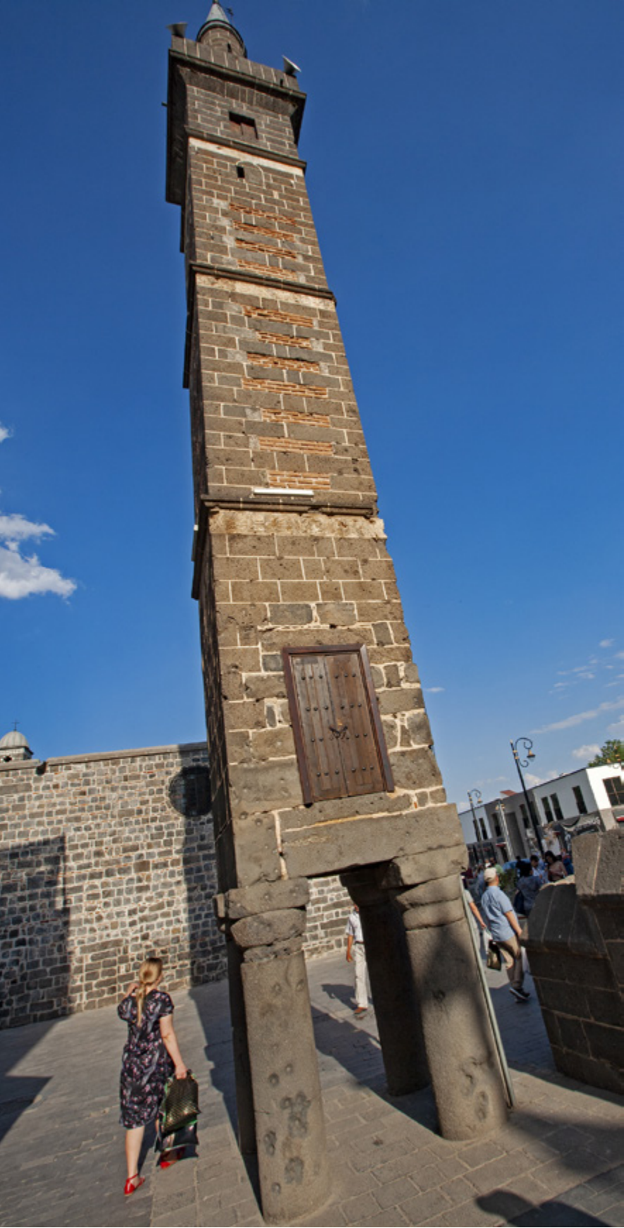
Minarete de los Cuatro Pies de Diyarbakir | Diyarbakir Four-Foot Minaret
