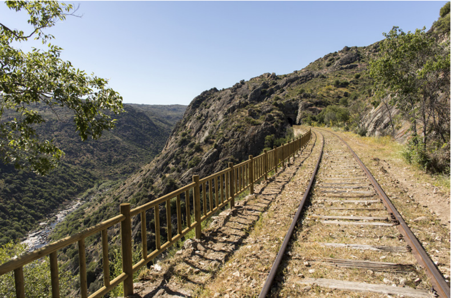
Train tracks bring us closer to our destination | Las vías del tren nos acercan a nuestro destino
