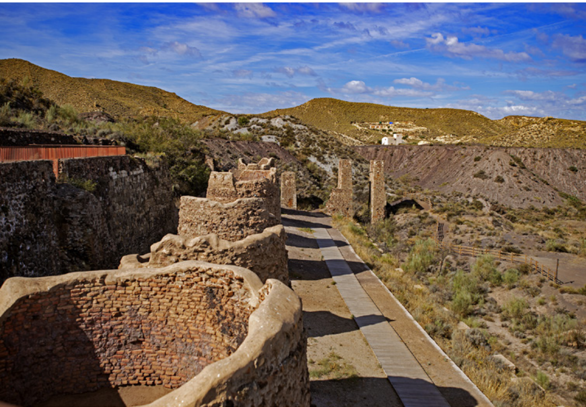
Calcination kilns in Lucainena de las Torres I Hornos de calcinación en Lucainena de las Torres
