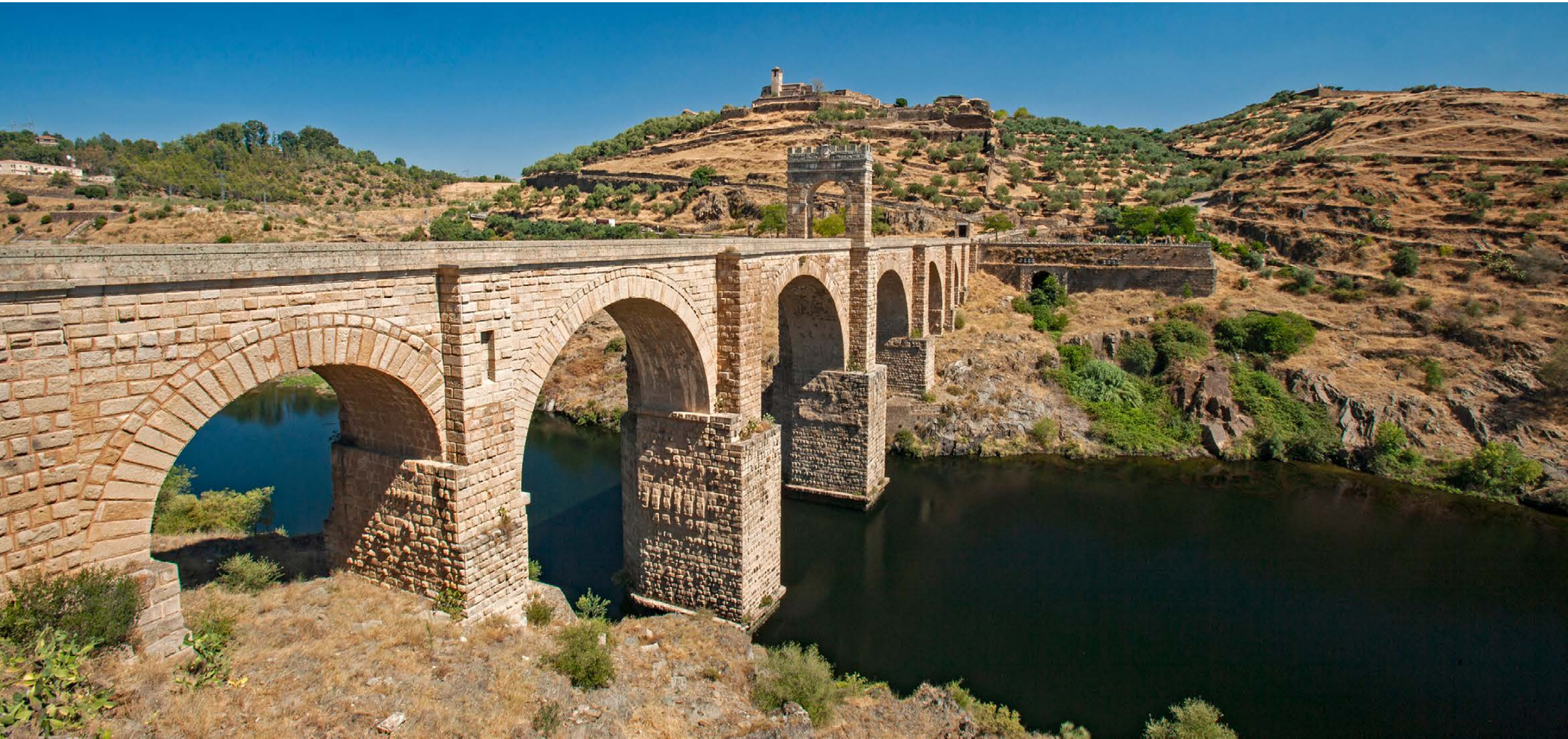
Puente romano de Alcántara | Roman bridge of Alcántara
