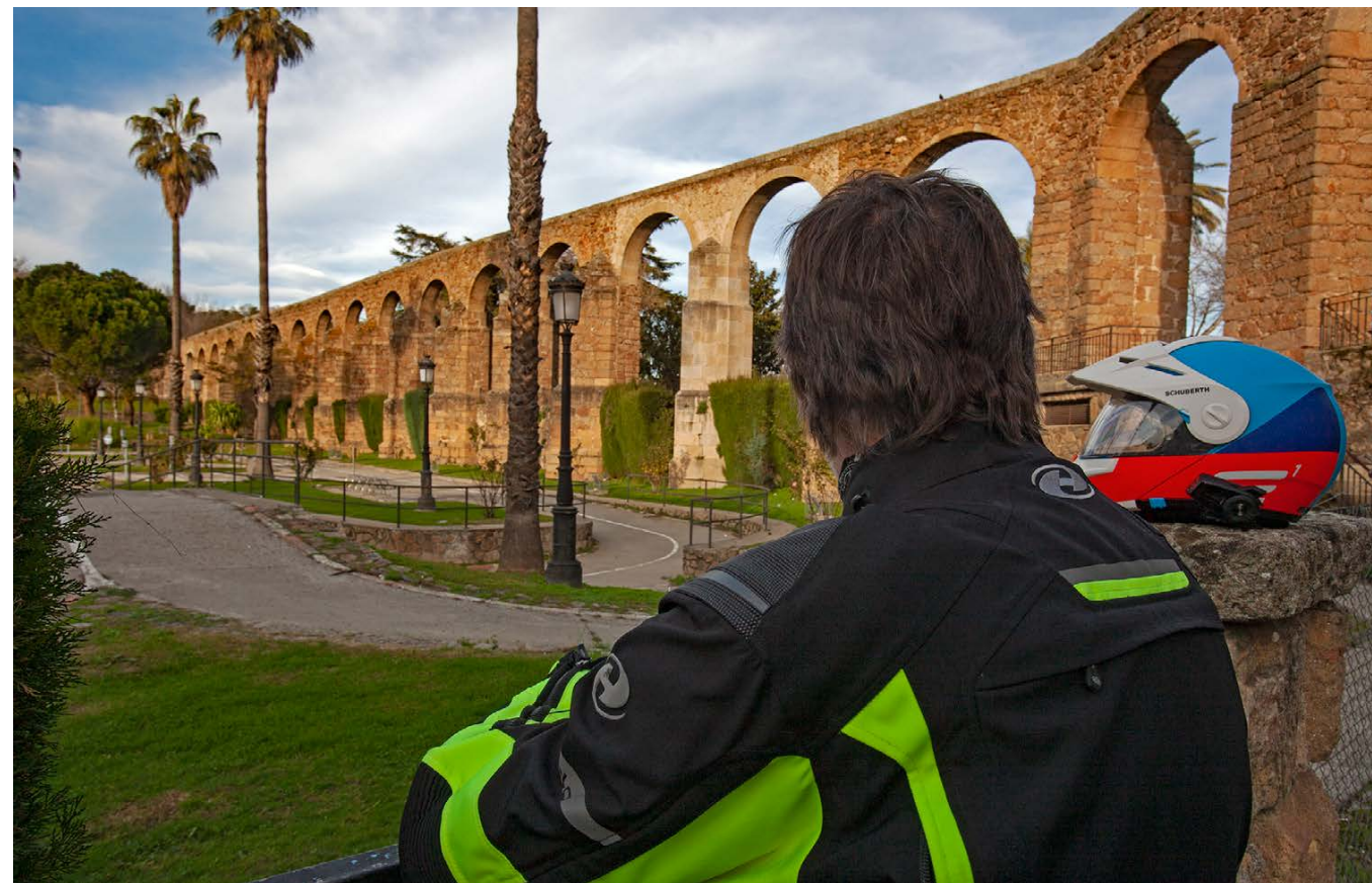
Plasencia Aqueduct | Acueducto de Plasencia
