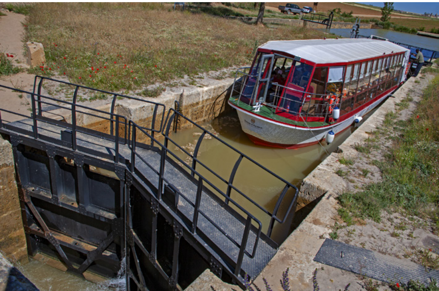
Crossing the lock at Tamariz de Campos | Salvando la esclusa en Tamariz de Campos
